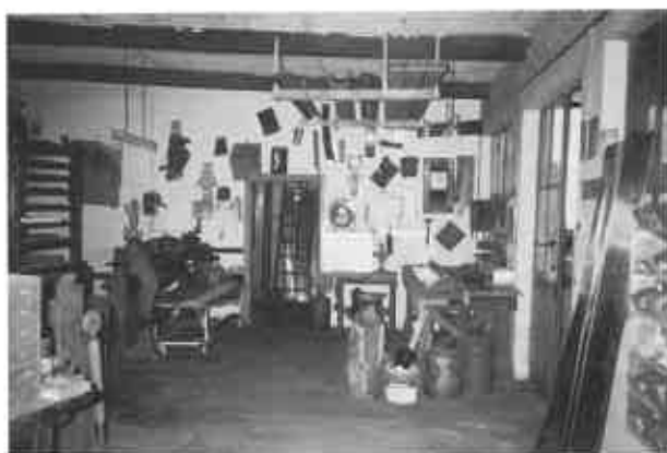
Alte Klempnerwerkstatt auf dem Grundstück Walramsneustr. 6 hinter dem alten Pferdestall. Die Werkstatt wurde etwa von 1950 bis 1994 in dieser Form genutzt.
