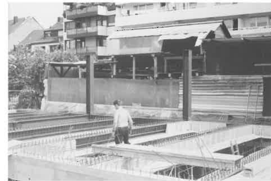
Bau der neuen Klempnerwerkstatt - schwere Stahlträger werden eingezogen. Im Hintergrund sind noch die alten Schuppen auf dem Freigelände zu erkennen.
