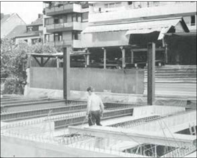
// Bau der neuen Klempnerwerkstatt – schwere Stahlträger werden eingezogen. Im Hintergrund sind noch die alten Schuppen zu erkennen.
